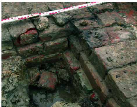
afbeelding 21 (geheel links): opbouw van de steunberen van de ringmuur: oerbrokken onderop, daarop grote kloostermoppen en bovenin stenen van een kleiner formaat.
